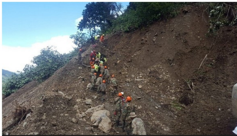
Rescatistas trabajan en el lugar del deslizamiento en la carretera que une La Paz con la población rural de Caranavi. / EFE
